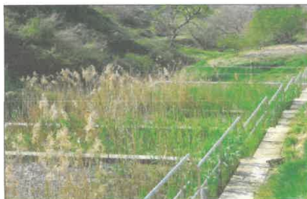
Figura N° 10: Fitodepuradores Plantados Con Carrizos
